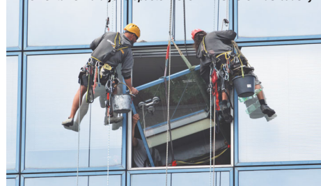
Demontáž okna a jeho spuštění okenním otvorem do budovy
