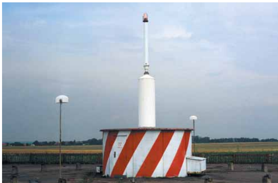
Typický vzhled všesměrového radiomajáku VOR používaného k radionavigaci
