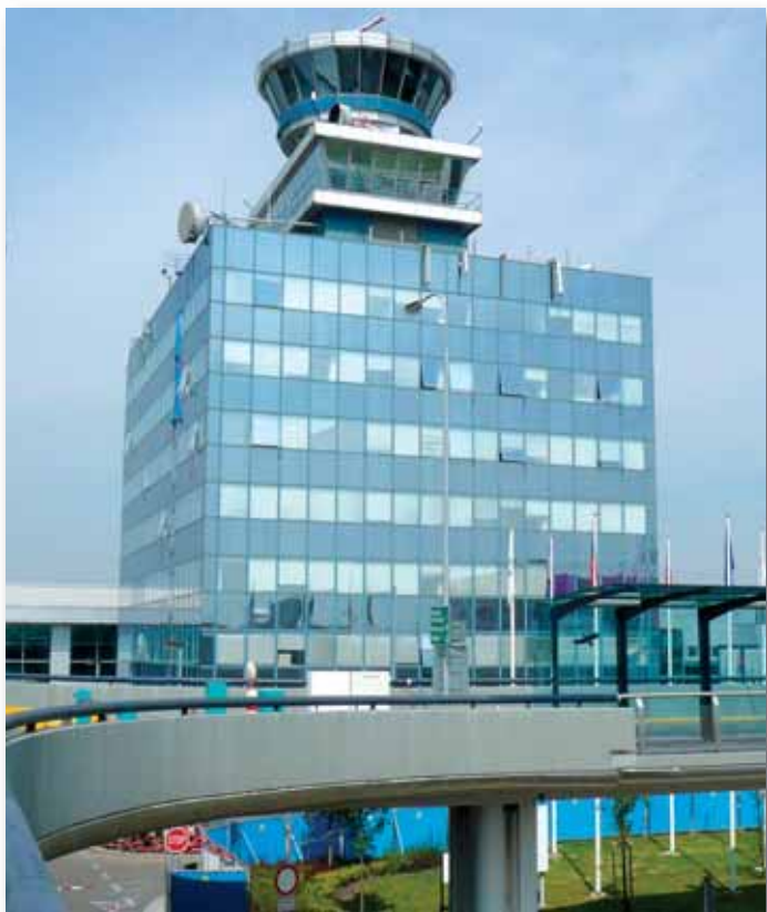
Technický blok již bez požárního schodiště. Rekonstrukce objektu začala.
