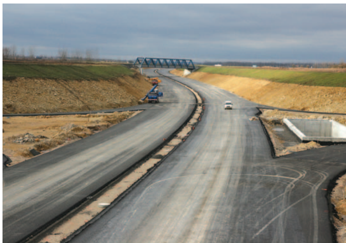
Rychlostní silnice R6 ve směru Praha – Pavlov se již pěkně zařezává do krajiny a ne-dočkaví motoristé by mohli nabýt dojmu, že už neschází mnoho do jejího zprovoznění.
