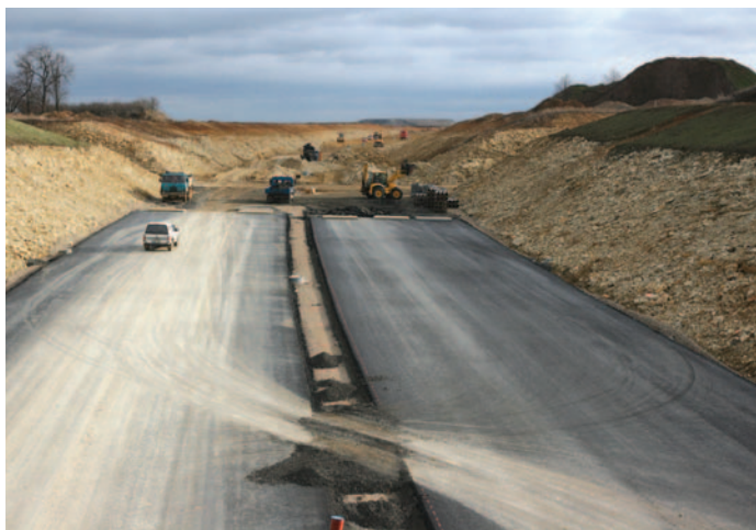
Druhý pohled – směrem na Prahu – však výmluvně dokumentuje, že tak brzy to zase nebude
