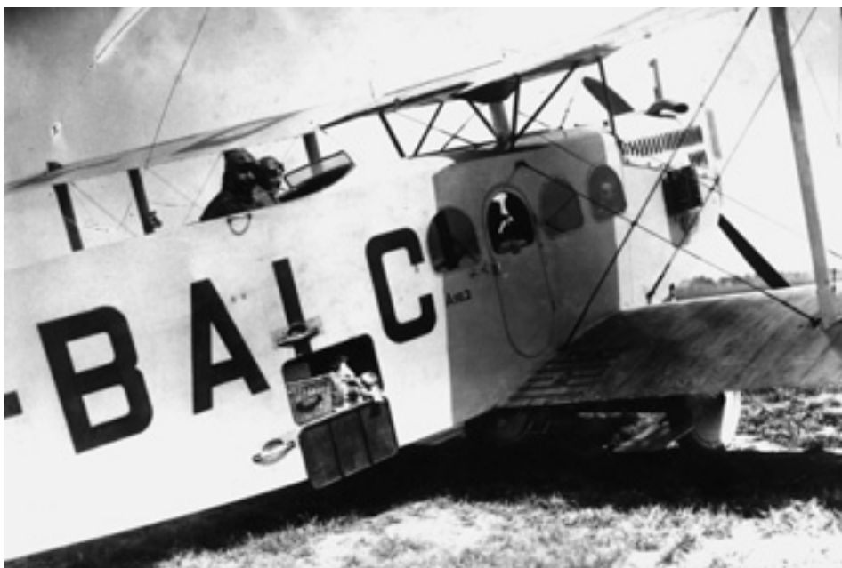
Dopravní „limousina“ Aero A.10, nasazená v roce 1924 Československými státními aeroliniemi. Byla určena pro tři až pět cestujících, posádku tvořil pilot (na levé straně letounu) a palubní mechanik (sedící vpravo poněkud vzadu). Dobře patrné jsou vstupní dveře do kabiny cestujících a otevřený zavazadlový prostor
