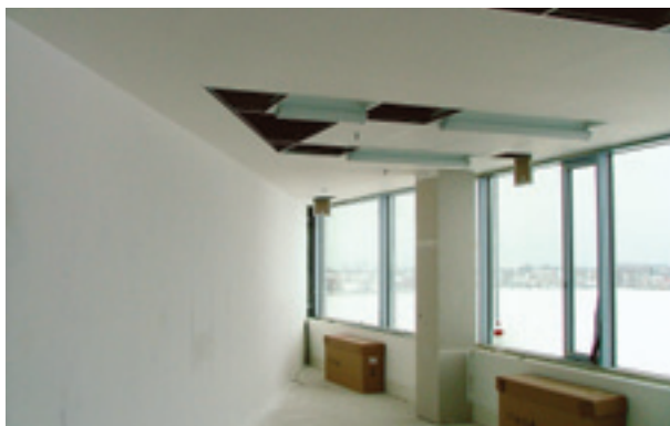
Pohled do jedné z nestandardních rohových kanceláří v administrativní části objektu potvrzuje, že i tady je již činnost zaměřena na dokončovací práce
