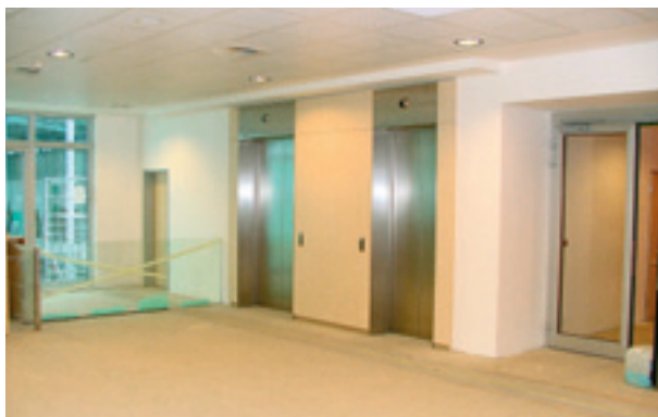
Z tohoto obrázku je patrné, že v provozním objektu je již doslova „vymalováno“. Jsme právě ve 2. NP v prostoru před turniketem pro opuštění provozního objektu (hranice bezpečnostních zón II. a I.) směrem do pasáže a před oběma výtahy
