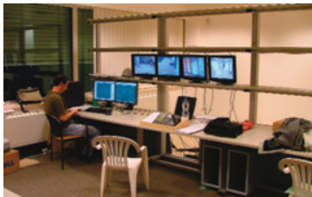
Tady jsme vstoupili do dispečinku BMS (Building Management System). Z tohoto „království“ bude personál dispečinku (CL) kontrolovat a řídit provoz všech systémů, potřebných pro chod celého střediska, a bdít i nad jeho zabezpečením. Jak obrazy z kamerového dohledu naznačují, částečně je tento systém již funkční
