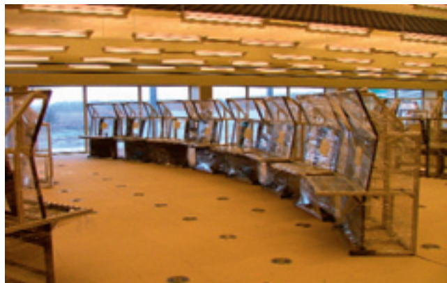
Tento snímek byl pořízen doslova několik hodin po transportu konstrukcí konsolet – základů budoucích řídicích pracovišť na sále ATS
