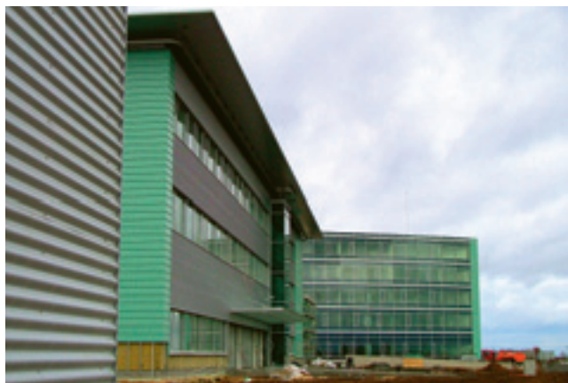
Pohled od jednoho ze dvou energobloků, umístěných za střediskem, na téměř dokončenou fasádu střediska. Garáže v prostřední části snímku jsou určeny výhradně pro technologická vozidla DPRO/ATMS
