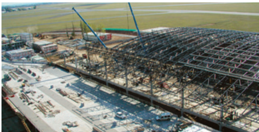
Nosná konstrukce terminálu Sever 2 s obloukovými nosníky střechy se na druhé straně už zakrývá potahem, aby stavba byla do zimy pod střechou. Před terminálem je zřetelná velká plocha v úrovni 1. patra, na kterou ústí estakáda. Tak budou rozděleny proudy aut k přiletům a odletům do dvou úrovní
