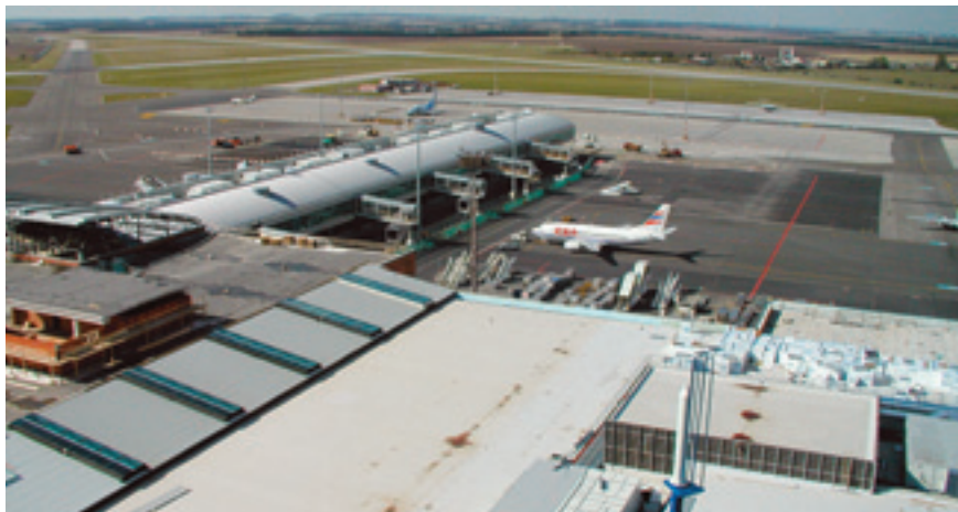
Prst C už je pod střechou a probíhají montáže vnitřních technologií, stejně jako v objektu spojovacího modulu
