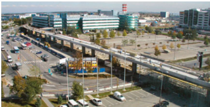
Šikmá estakáda, která propojí úroveň vozovky před terminálem Sever s 1. patrem Terminálu Sever 2 je v hrubé stavbě hotova
