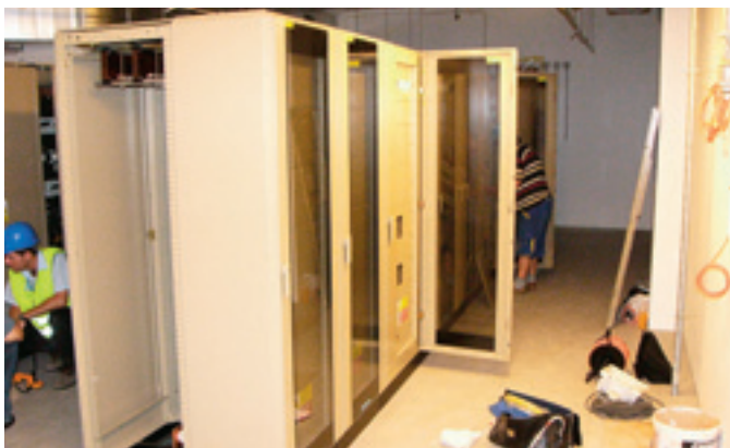
Montáž rozvaděčů silnoprůdu v suterénu, kde právě probíhala kontrola osazení rozvaděčů
