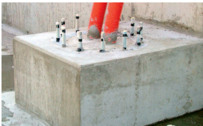
Kotevní blok pro anténní stožáry. Takových bloků bude na střeše provozního objektu deset
