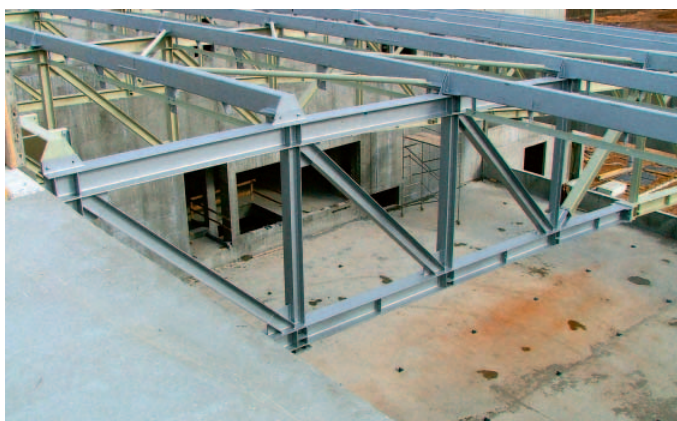
Pohled do budoucího sálu ATS. Průhled střešními vazníky (jejich rozpětí je 29,5 metru a hmotnost každého z nich 20 tun) naznačuje, že díky tomuto řešení nebude plocha sálu ATS narušena žádným sloupem. Ten velký obdélníkový otvor naznačuje budoucí propojení sálu ATS a ITS
