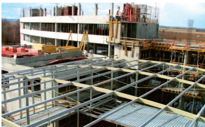
Pod námi střešní konstrukce pasáže, v pozadí sloupy 5. NP administrativní budovy naznačují, že i tato část objektu bude v nejbližší době dokončena
