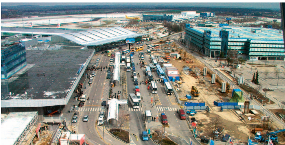
V prostoru před terminálem se budují opěrné sloupky pro estakádu, která se bude šikmo zdvíhat k úrovni 1. patra nového terminálu
