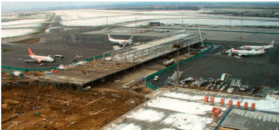
Na severním okraji stavební jámy pro terminál už se rýsuje prst C, v popředí je střecha spojovacího objektu mezi novým a stávajícím terminálem
