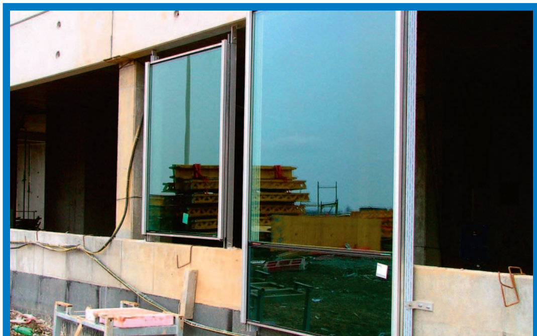
Horká aktualita z výstavby IATCC v Jenčí. Na snímku Jiřího Houry jr. vidíte vzorky skel, první náznak barevného řešení fasády. Vpravo průhledné a neprůhledné sklo kanceláří, vlevo průhledné sklo schodišť
