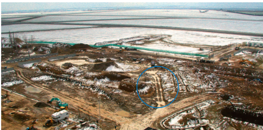
Výhled na provozní plochu, v pozadí startuje ČSA z RWY 31, v popředí není bojiště, ale zhruba poloviční část staveniště budovy terminálu Sever 2. Stavební stroje už netrpělivě čekají, až se vyřeší překládka optických kabelů (šikmá trasa v kroužku), které přenášejí radarová data pro řídicí stanoviště
