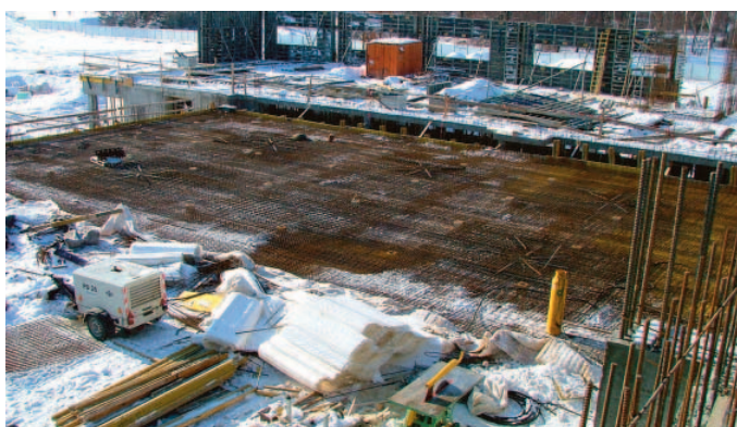
Pohled na část vybetonované podlahy budoucího sálu ATS (současně stropu nad CST sálem), v pozadí příčky 2. NP, které vytvářejí obvodový plášť relaxačních prostor personálu ATS
