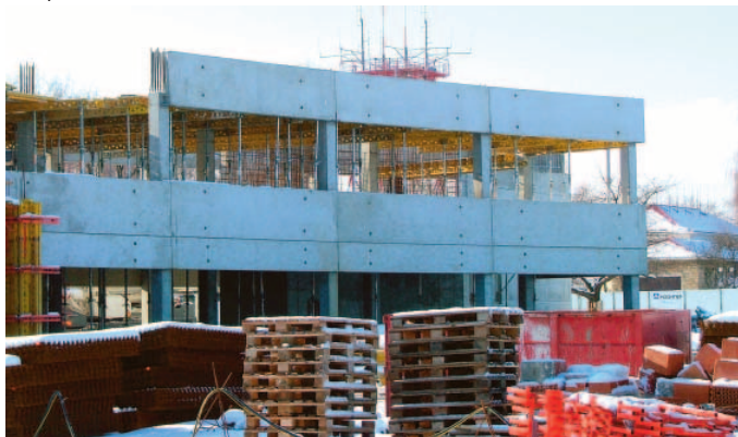
Čelní pohled na administrativní část objektu. Osazené parapety 3. NP a bedně stropní konstrukce 2. NP postupně zakrývají výhled na historickou anténní věž vysílacího střediska
