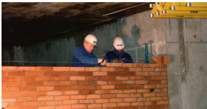
Suterén objektu – bylo zahájeno vyzdívání vnitřních příček
