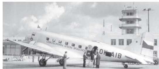
Spolupráce ČSL a ČSA pokračovala i na Ruzyni. Douglas DC-2 (v. č. 1582) OK-AIB byl druhým zakoupeným strojem tohoto typu.
