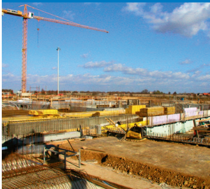
Snímek ukazuje aktuální pohled na staviště (4. 11. 2003). V říjnu už stavební práce nabraly rychlé tempo a díky přízní počasí nebyly hlášeny žádné zásadní problémy ani ohrožení časového harmonogramu.
