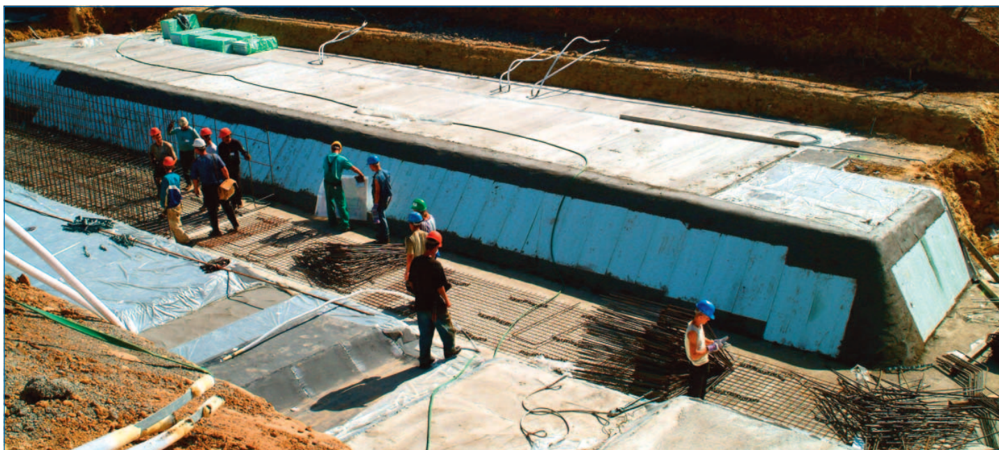
Ani při slavnostní ceremonii, která probíhala jen o kousek dál, se nezastavily práce na budování základů stavby
