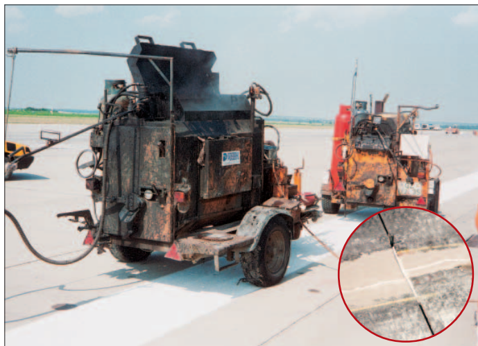
VÝMĚNU zálivkové hmoty v dilatačních spárách prováděly tyto zalévače spár. Na detailním snímku dokončená oprava výtluku plastbetonem.
