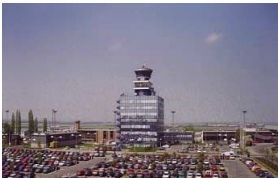
Současné provozní a administrativní prostory ŘLP ČR neumožňují plánovaný rozvoj firmy. Nové středisko v lokalitě Jeneč by mělo začít fungovat v roce 2006.
